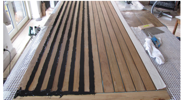
Überquellende Dichtmasse ist kein Problem.
