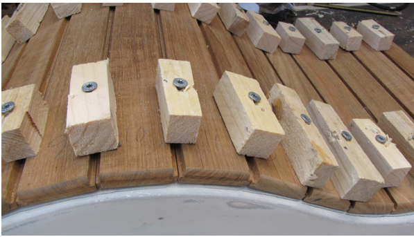
Verschraubungen in den Fugen.
